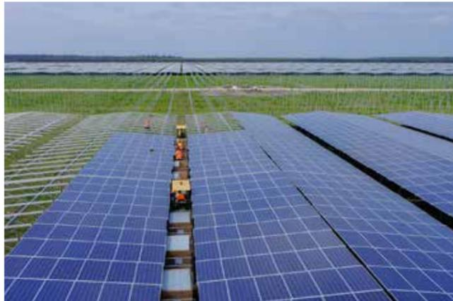
Ce projet développé par Neoen, l'un des principaux acteurs français des énergies renouvelables, représente une puissance globale de 300 MWc (mégawatts-crête). L'installation qui s'étend sur une surface de plus de 250 hectares, est composée de 25 tranches de 12 MWc. Le parc est directement raccordé au réseau à très haute tension.
